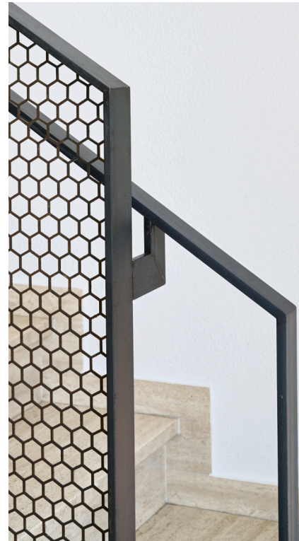
Gelaserstes Stahlgeländer, Detail mit Handlauf
